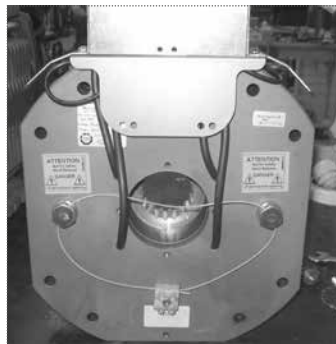
Fig. 16. fijación de tornillos para maniobra manual para DFX.
